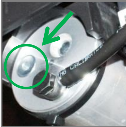
- Orifice de remplissage d'huile sur la pompe.
